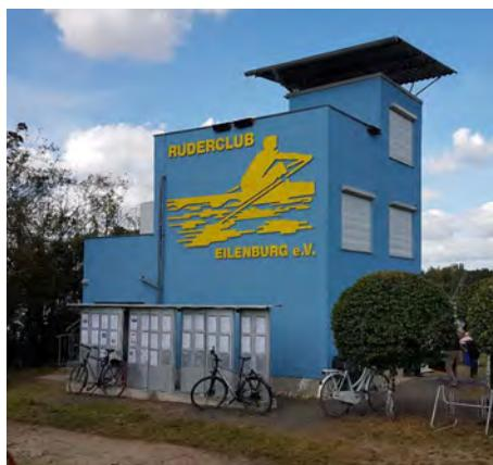
abgeschlagen, grundiert, ausrepariert, Teile des Turms mit Gage armiert. Klingt schnell, ist es aber nicht. Danach gingen Vater und Sohn ans Werk und brachten mit einer Putzschleuder aus DDR-Zeiten einen Putz auf die Wand welcher dem alten absolut ähnlich sieht, für mich vorher unvorstellbar.
